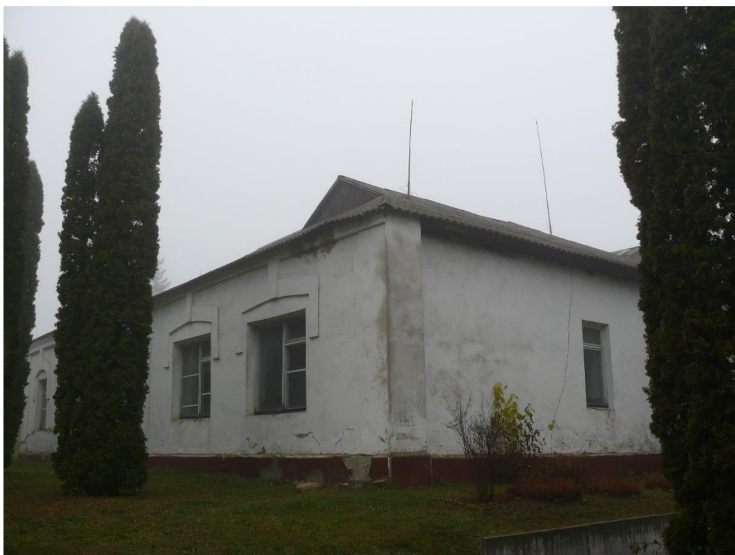
Будинок ремісничого училища (II пол. XIX ст.), вул. Подільська, 34
