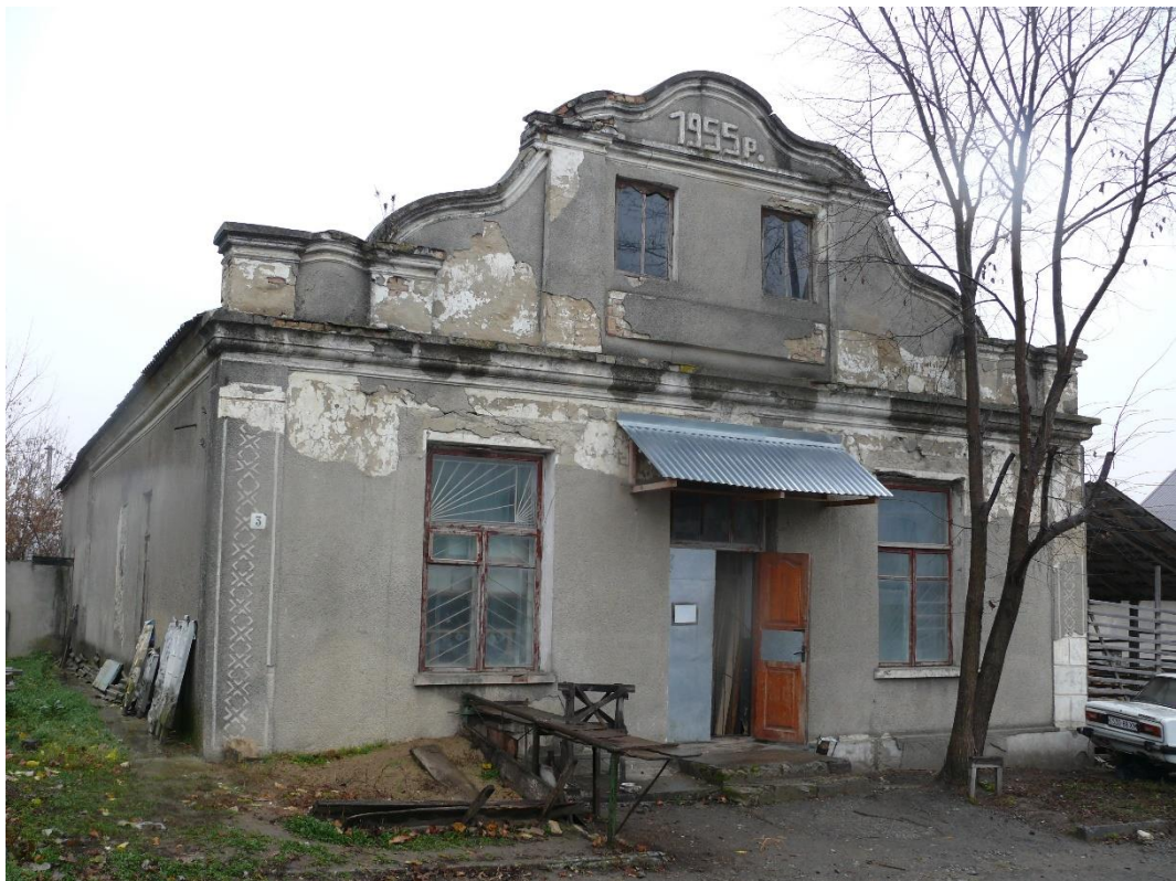
Будинок житловий (кін. XIX – поч. XX ст., 1955 р.), вул. Подільська, 3
