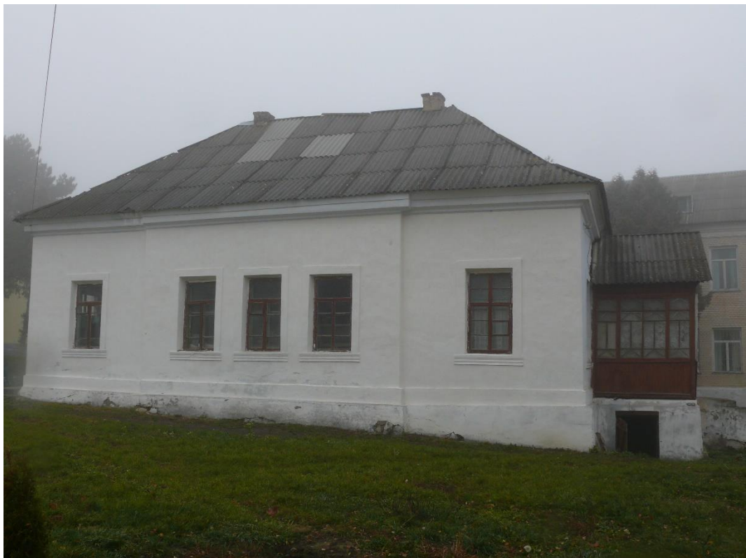
Плебанія (будинок священника, 1861 р.), вул. Подільська, 24
